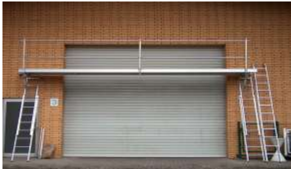
Abb. Konsolgerüst mit Alu-Steg 6m als Wandgerüst oder als Dachgerüst verwendbar
