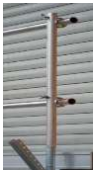
Abb. Geländerpfosten mit Rundspannhaken
