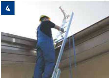
Geländer-Pfosten einhängen
