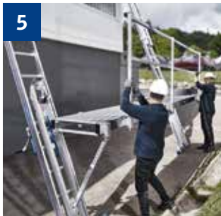
5 Gelände in Arbeitsbühne einstecken und bei Bedarf Personen-Fangnetz oder Rückseitengeländer anbringen.
