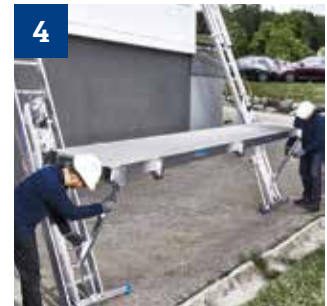
4 Arbeits-Plattform und Stütze auf dem Transport-Schlitten einhängen.
