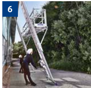
6 Schlitten und Bühne mittels Seilwinde nach oben kurbeln und in Arbeitsposition einrasten.
