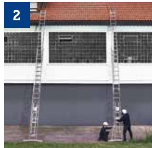
2 Verstärkte BAVARIA Leitern als Stützleitern aufstellen.
