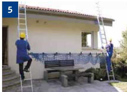
Geländer mit Netz aufbringen
